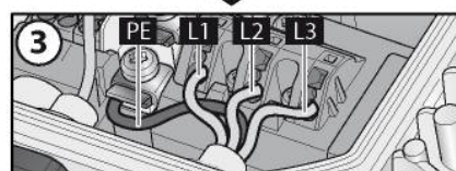
Иллюстрация 2: Подключение проводов к клеммам
