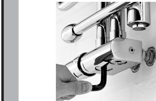
DK: Fastspænd ventilen mod radiatoren
