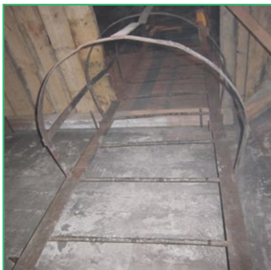
Лестница из стали
