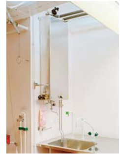
Модуль Pharma-X установлен как охладитель для использования в месте применения в AstraZeneca, Швеция.
