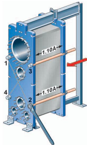
Этап 2: После этого болты затягиваются попаременно-диагонально, как показано на следующем рисунке. Затягивая используемые болты, измеряйте расстояние A.
