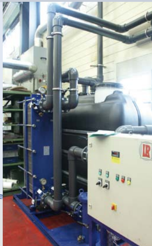
Охлаждение смазочного масла профильного прессы
