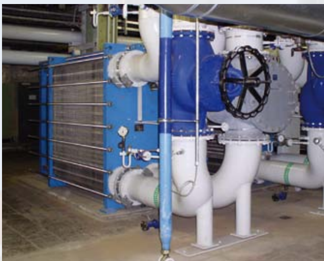
Охлаждение установок лазерной сварки в автомобильной промышленности
