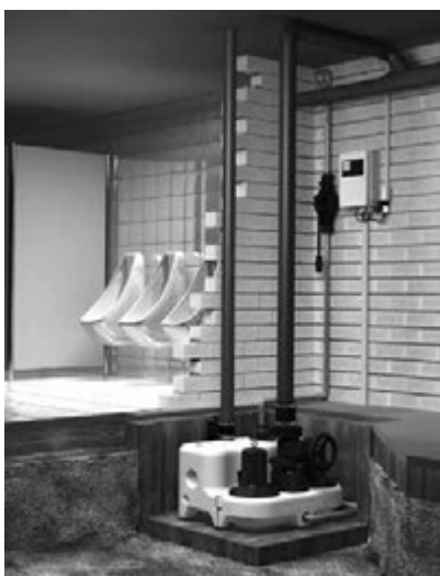
Рис. 84. Пример установки Multilift M в приялке в подвальном помещении здания
