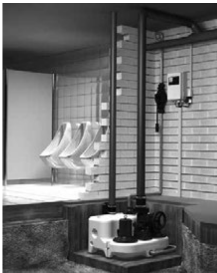
Рис. 99. Пример установки Multilift MLD в приемке в подвальном помещении здания
