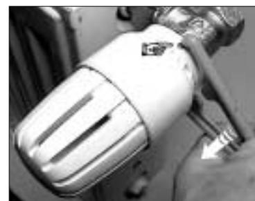
С помощью шестигранного ключа SW2 вернуть два стопорных штифта. В этом положении термоголовка прочно закреплена на клапане, и зубчатое кольцо ② может свободно поворачиваться.
