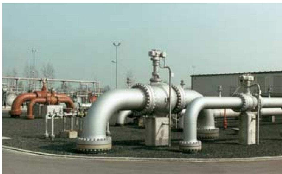
Клапаны регулирования расхода на подземном хранилище газа, Германия
