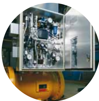
Интегрированная система управления Каждый регулирующий клапан поставляется со своей индивидуально спроектированной системой управления.
