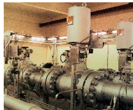
Клапан HIPPS 16" ANSI 1500 на компрессорной станции, Германия.
