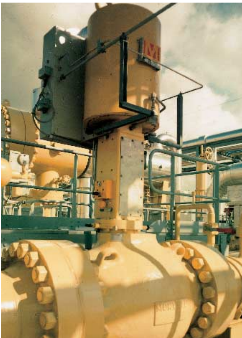
Клапан HIPPS 16" ANSI 1500 на компрессорной станции, Германия.
