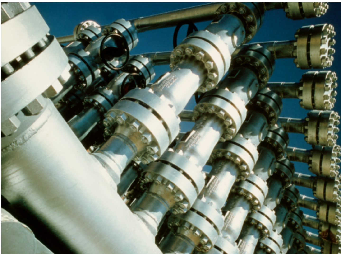
Отсечные и безударные обратные клапаны 6" ANSI 900 на коллекторе закачки воды в нефтяной пласт, северная Африка
