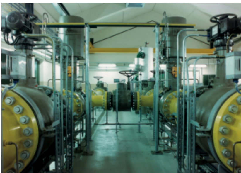
Отсечные и безударные обратные клапаны 6" ANSI 900 на коллекторе закачки воды в нефтяной пласт, северная Африка
