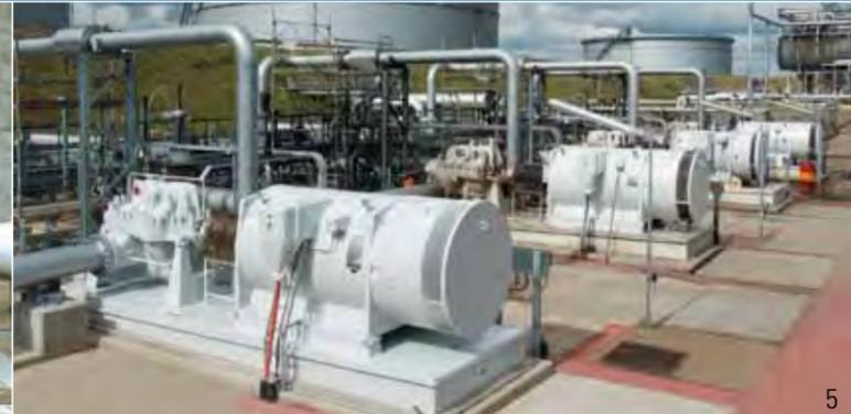
1) Регулируемый привод насоса, 1500 кВт, 2 x 900 В, диапазон регулирования 400 – 1500 мин<sup>-1</sup>
