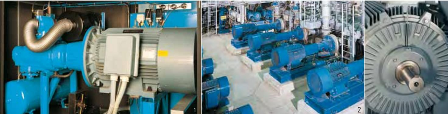
1) Двигатель с поверхностным охлаждением, IP55, модель IM B35, для привода компрессора; 90 кВт, 400 В, 2975 мин<sup>-1</sup>
