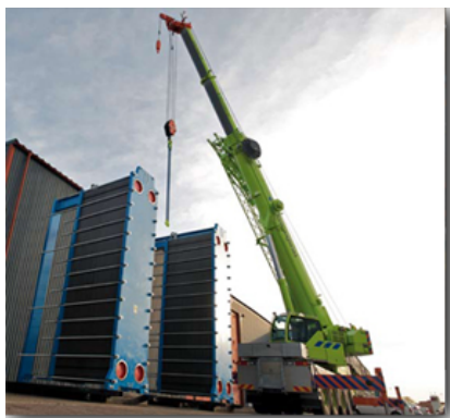
Эти огромные пластинчатые теплообменники - это два из семи, установленных для охлаждения кварталов Стокгольма с использованием морской воды в качестве хладагента.
