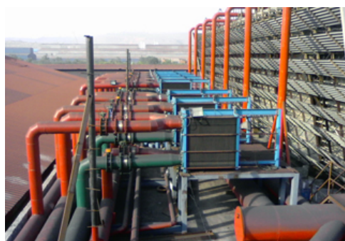
Если тепловая нагрузка неопределенная или изменяется в широких пределах, то пластинчатые теплообменники являются гибким и экономичным решением.
