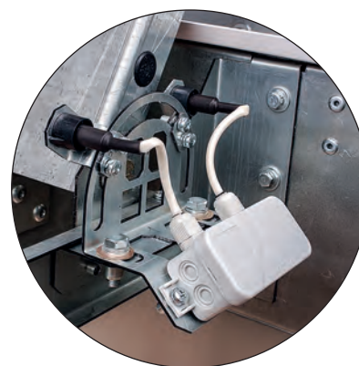
Блок контроля конечных положений крышки люка (БККП)
