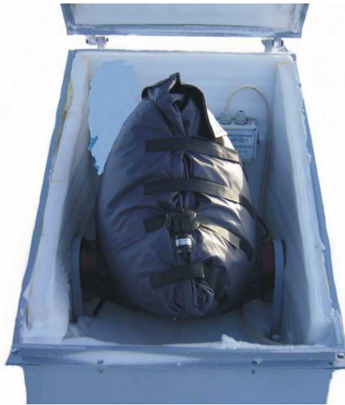
Рисунок И.1 - Внешний вид «ГиперФлоу-3Пм» в кожухе КРАУ4.127.022 и утеплителе КРАУ4.127.024
